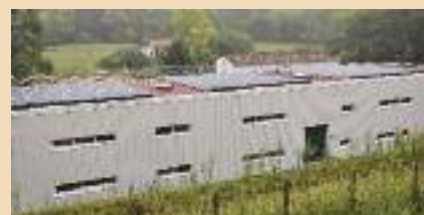
Installation photovoltaïque sur la toiture du centre Technique Municipal de Saint-Pée-sur-Nivelle.
